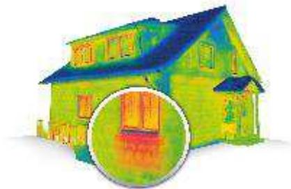
Auch in diesem Infrarotbild ist eine typische Wärmebrücke zu erkennen: die Heizkörpernische. An dieser Stelle ist das Mauerwerk häufig ausgespart, was neben der erhöhten Wärmezufuhr durch den Heizkörper dazu führt, dass in diesen Bereichen erhebliche Wärmedurchgänge zu verzeichnen sind. Im Thermogramm wird dies durch die rötliche Einfärbung unterhalb der Fenster deutlich.
