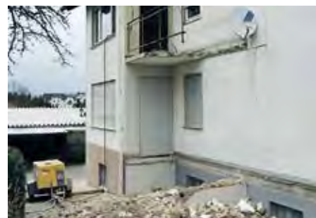
Abb. 55: Abbruch von Stahlbetonplatten zur Wärmebrückenvermeidung
