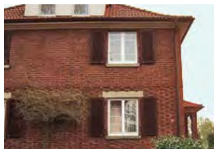
Abb. 8: Backsteinfassade mit sichtbarem Fenstersturz aus Beton
