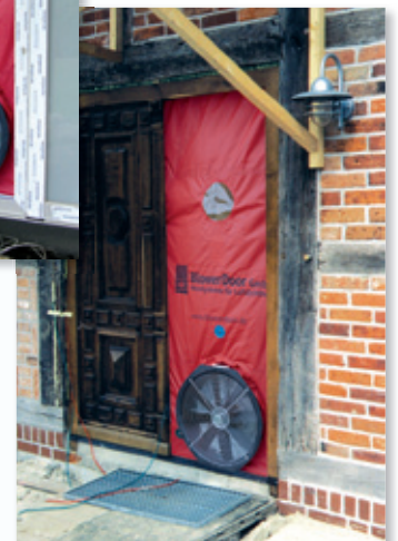
BlowerDoor Messung im Rahmen einer Fachwerksanierung
