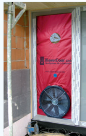
BlowerDoor Messung eines neu gebauten Einfamilienhauses
