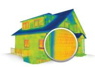
Im Thermogramm ist deutlich zu erkennen, dass im Bereich der Außenwand ein erhöhter Wärmedurchgang stattfindet. Sichtbar wird dies an der rötlichen Einfärbung der Wandfläche. Eine effizient gedämmte Wand wäre im Wärmebild grün.
