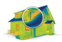
Luftundichtheiten führen neben Wohnkomfortmängeln und Wärmeverlusten auch zu bauphysikalischen Problemen wie z.B. Kondenswasserausfall in der Dämmung. Diese Undichtheit erzeugt aufsteigende Warmluft, die die Glaubenseite erwärmt, was durch die orange-rote Farbe der Gaubenverkleidung sichtbar wird.
